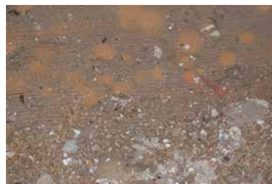
Restes de material dipositat sobre la pastera
