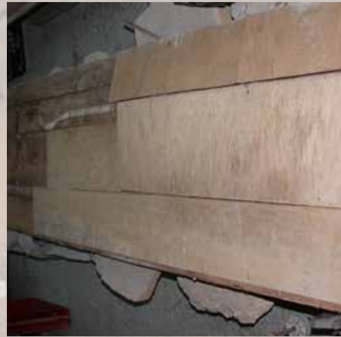
Fulloles sobreposades sobre els travessers
