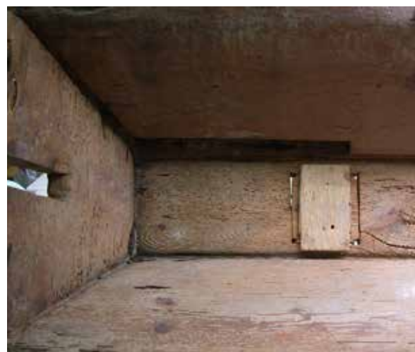
Interior de la part inferior de la pastera després de la seva restauració
