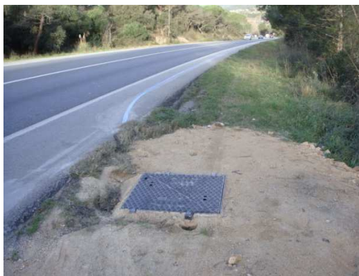
Exemple de l'estat de la canalització acabada
