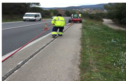
Centrador plàstic per homogenitzar la distribució del morter.
