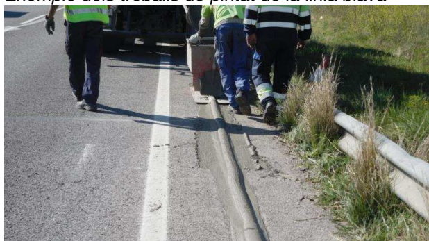
Procés de rebliment de la rasa amb morter.
