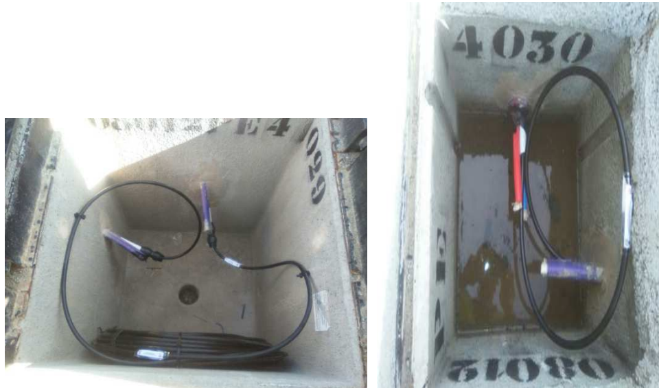
Exemples Terminació microductes en pericó
