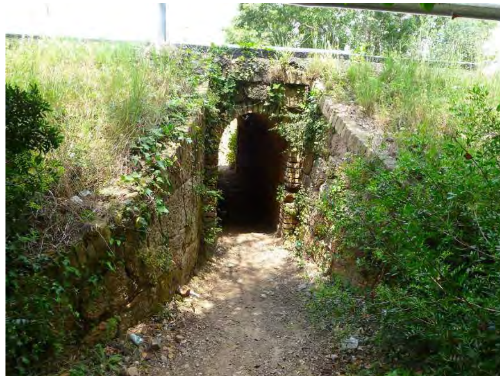
Entrada obra de drenatge OD-1.1 (CRTA2).
