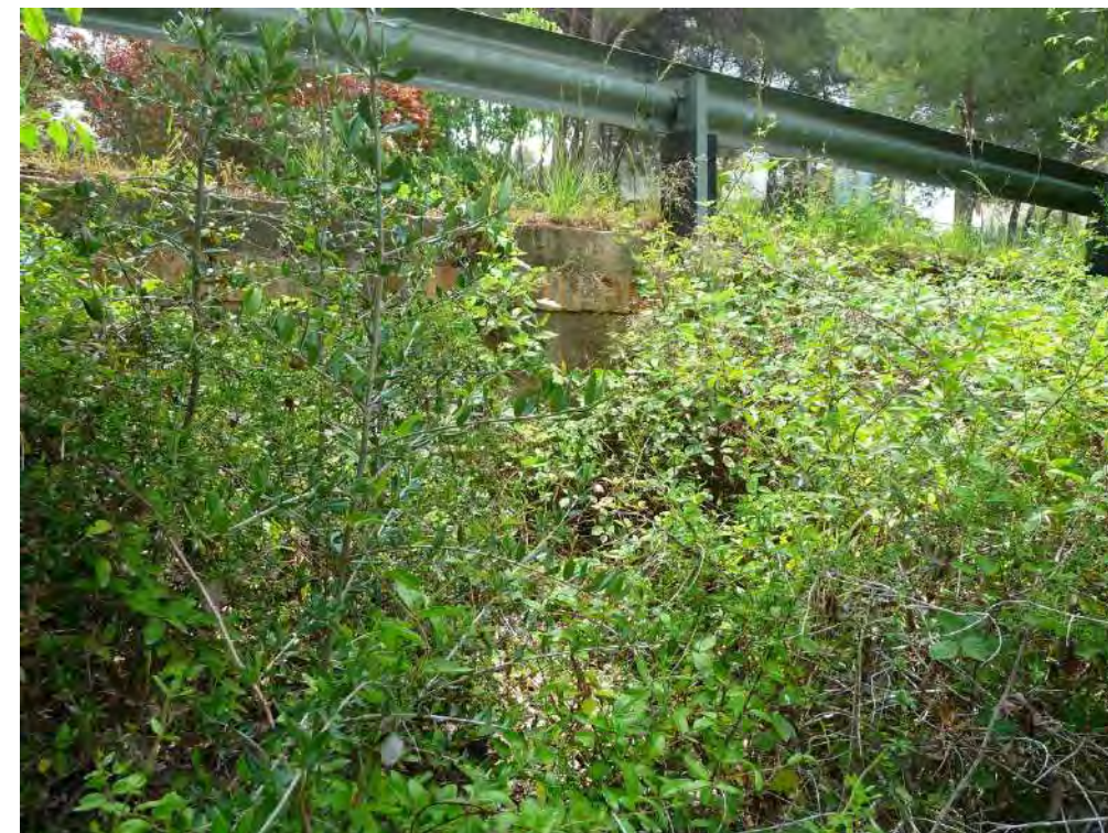
Sortida obra de drenatge OD-0.1 (ROT-C1).
