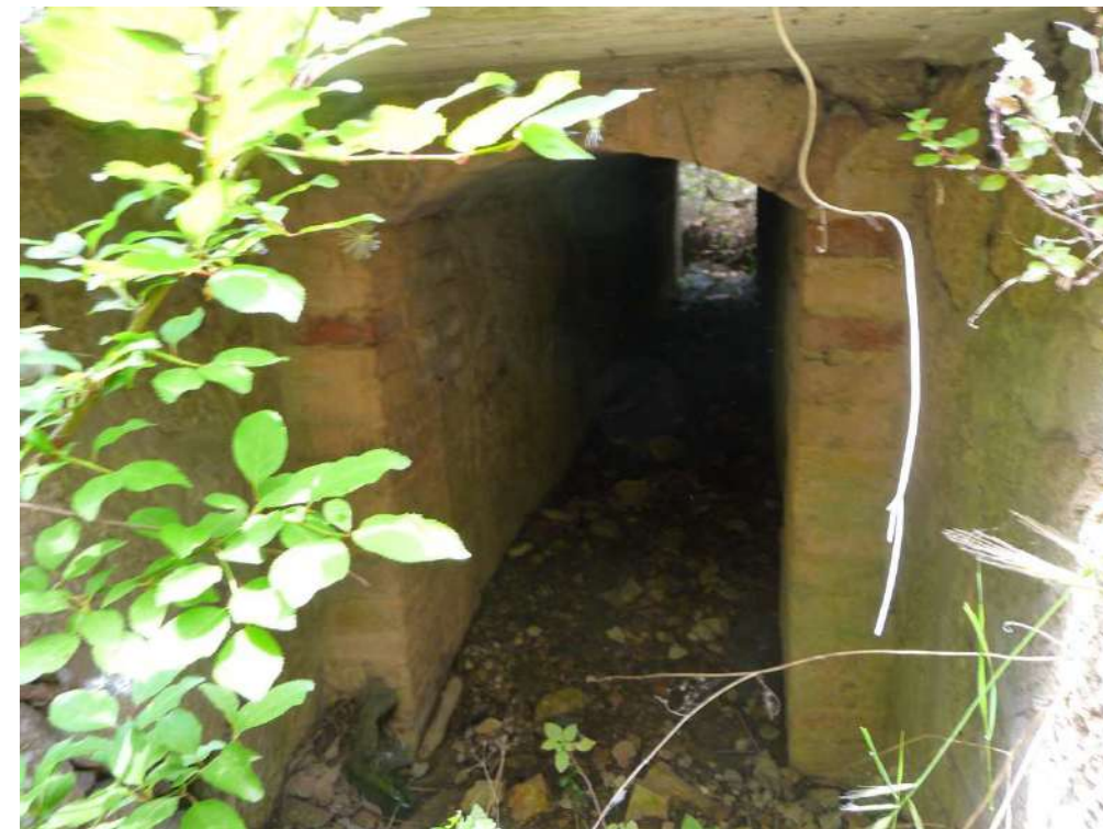
Entrada obra de drenatge OD-0.1 (ROT-C1).
