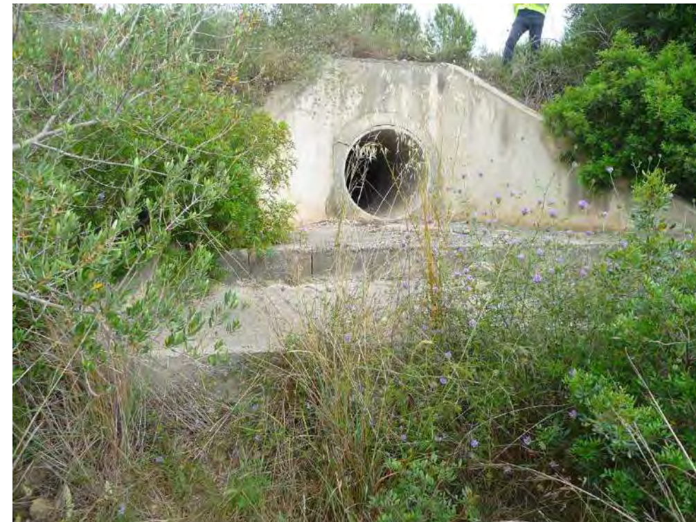
Sortida obra de drenatge OD-0.1 (CTRA2).
