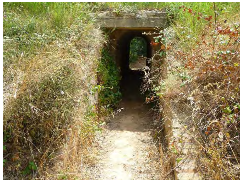
Sortida obra de drenatge OD-1.1 (CRTA2).
