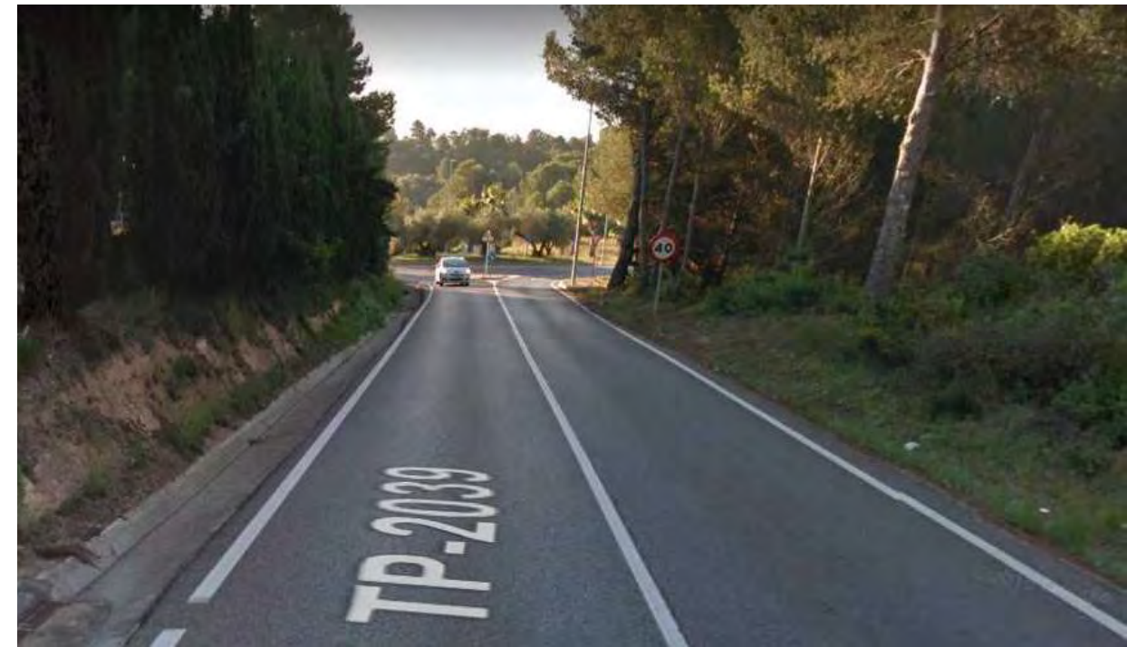
PK 3+050 (Rotonda existent d' accés a la urbanització Pinalbert i al Golf Costa Daurada)
