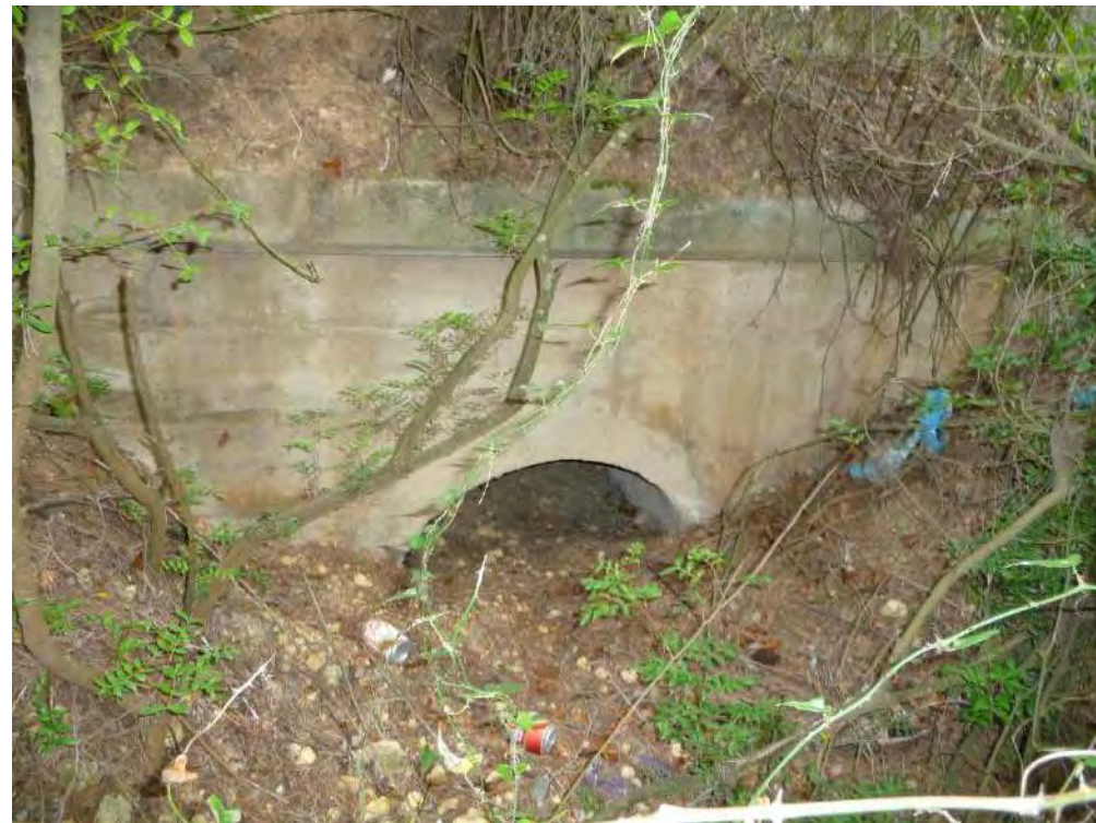
Sortida obra de drenatge OD-2.1 (CRTA1).
