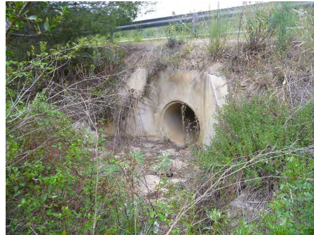
Entrada obra de drenatge OD-0.1 (CTRA2).
