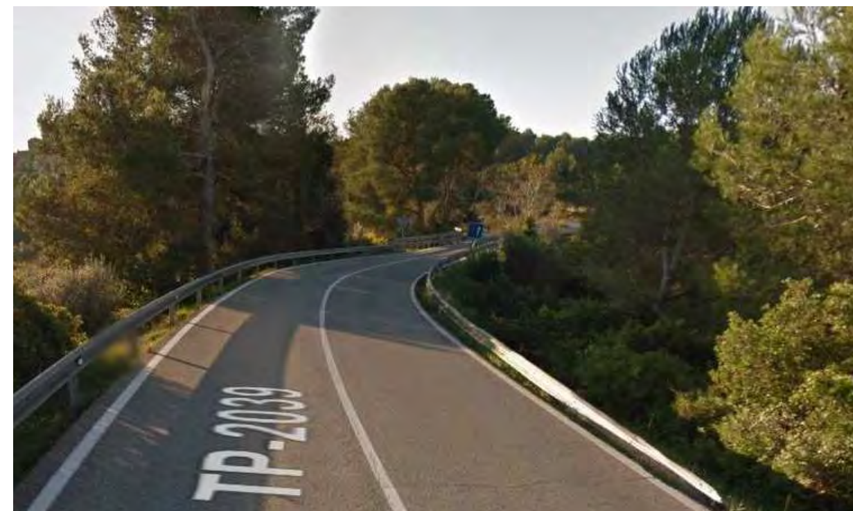
PK 3+250 (Obra de fàbrica sobre la riera del barranc de la Móra)
