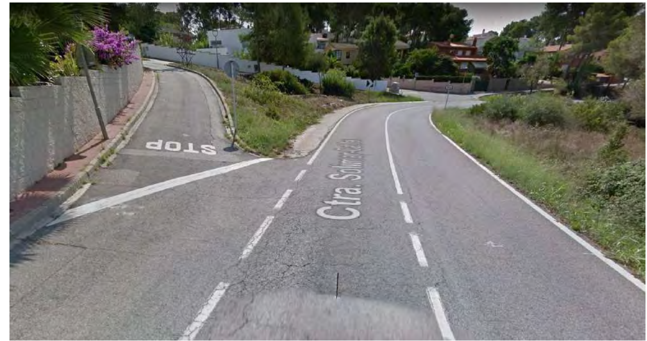
PK 5+650 (Intersecció amb la Rambla del Lleó Menor – urbanització Monnars)
