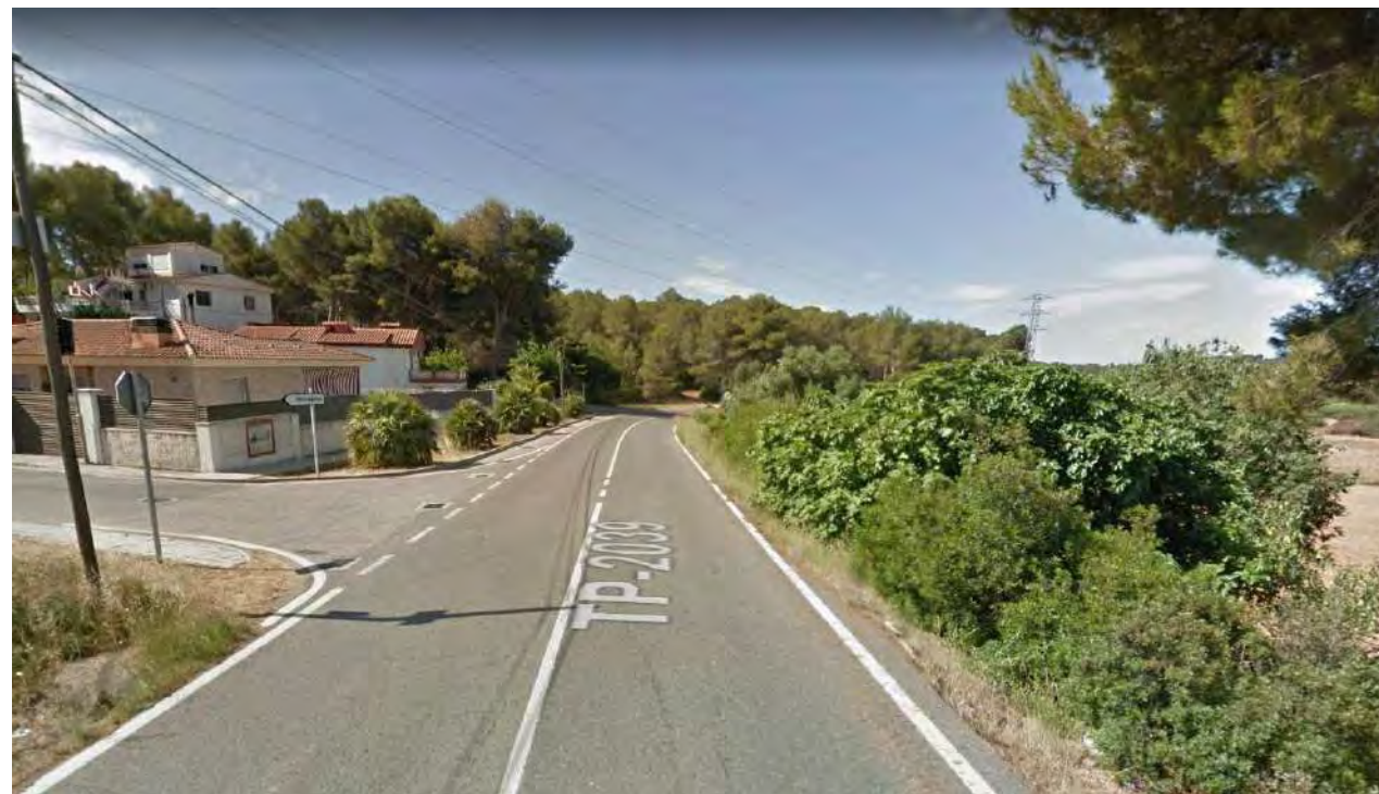
PK 4+950 (Intersecció amb el carrer de la Roca Bruna i del carrer del Puntaire – urbanització Entrepins)
