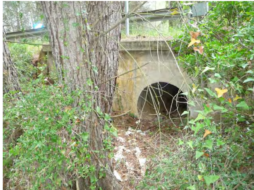
Entrada obra de drenatge OD-2.1 (CRTA1).
