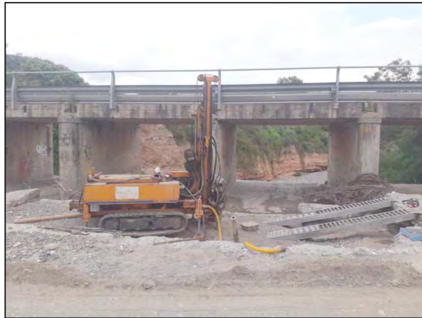
Fotografia 1. Vista de l'emplaçament de la màquina durant la realització del sondeig a rotació amb bateria contínua S-1.
