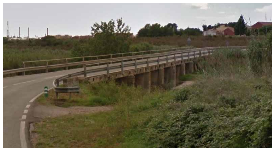
Figura 1. Pont sobre la Riera de la Selva
